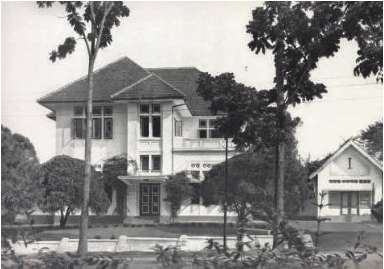
Het nieuwe hoofdkantoor Dagoweg 51 te Bandoeng is op 1 mei 1941 in gebruik genomen.
