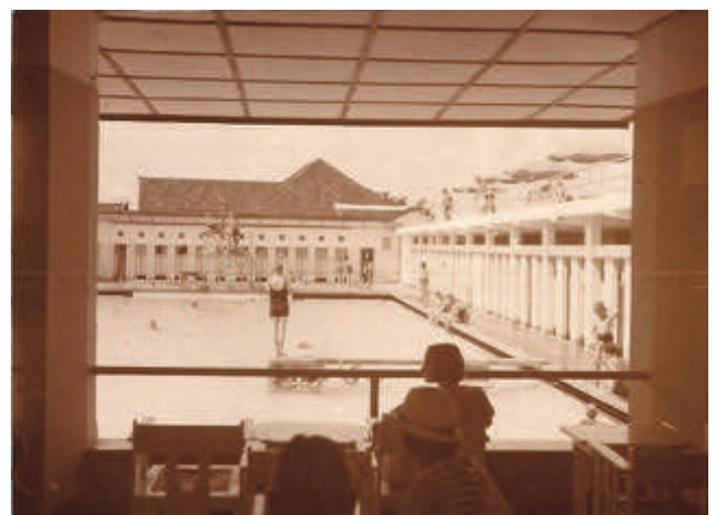
De eerste opdracht voor IBIV in 1936: verbouwing van zwembad "t Centrum" in Bandoeng.
