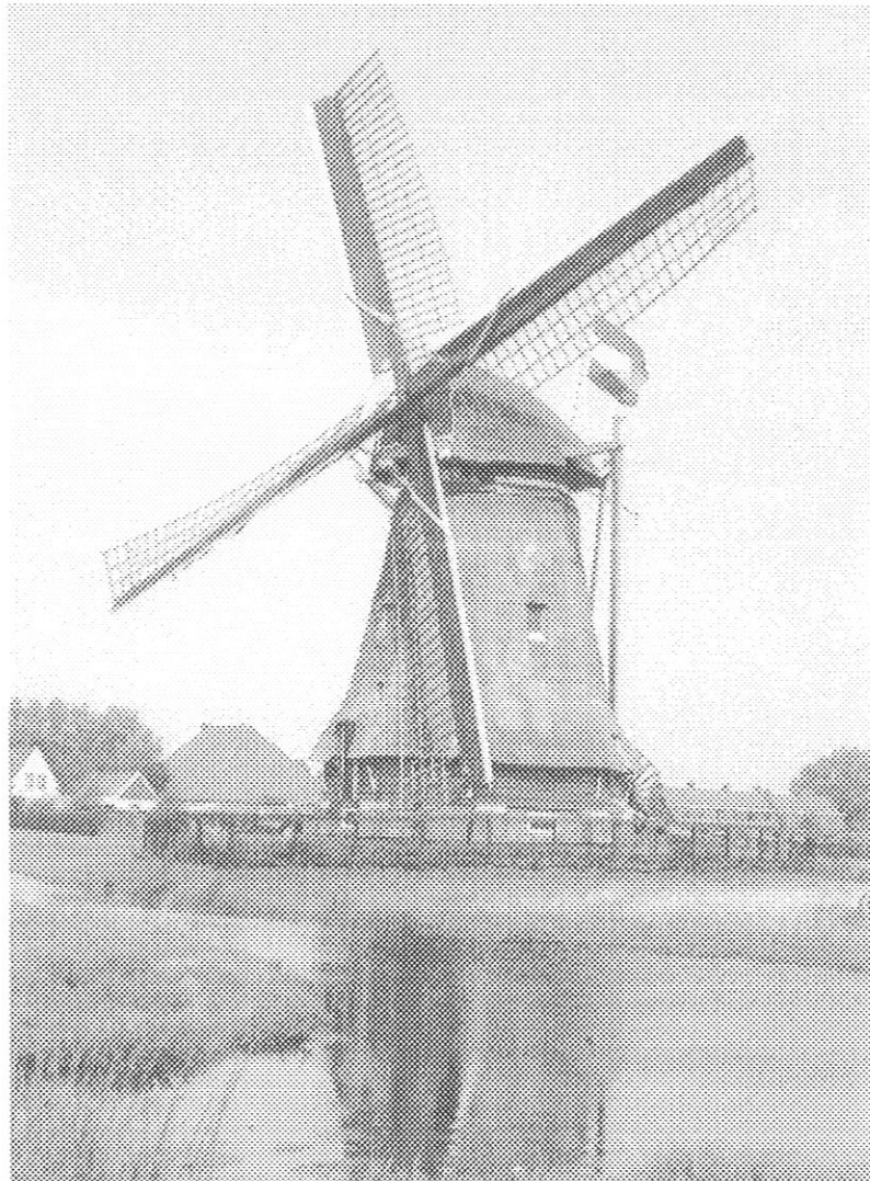
De meelmolen De Koker met op de achtergrond de bebouwing van Wormer. Deze molen is geen stellingmolen maar een grondzeiler.
