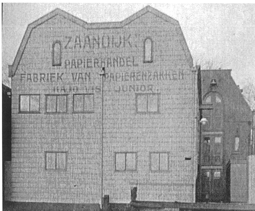
De houten achtergevel van het bedrijfspand Langedijk 72
